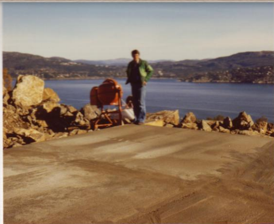
Platen er støpt ferdig.
