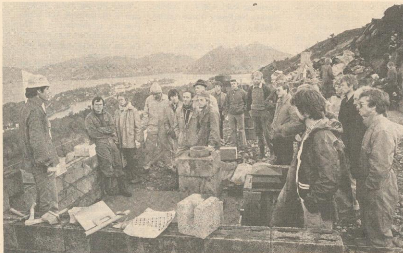
Flere og flere av tomtene blir nå byggeklare, og på onsdag var alle selvbyggerne invitert for å lære hvordan de skulle støpe grunnmur.
