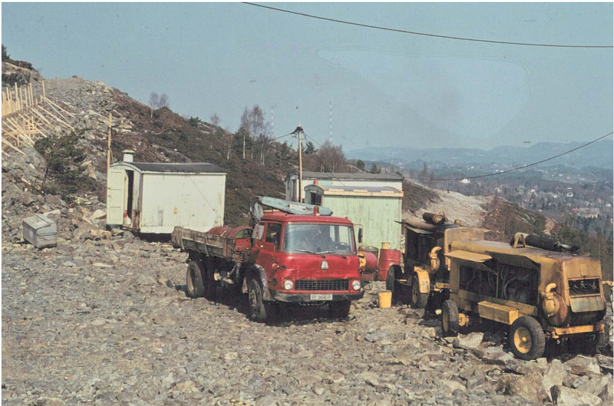
Brakkene ved krysset. Vei videre oppover fra krysset er blitt grovplanert og den lange muren er under oppføring.
