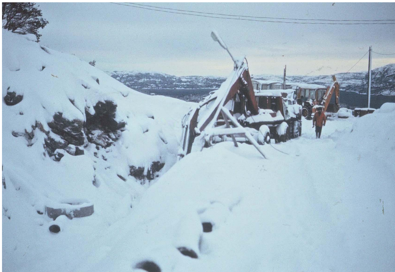
Vintervær og rørlegging i vei 3 rett sør for krysset. I bakgrunnen ser vi brakkene som nå er flyttet opp til krysset.
