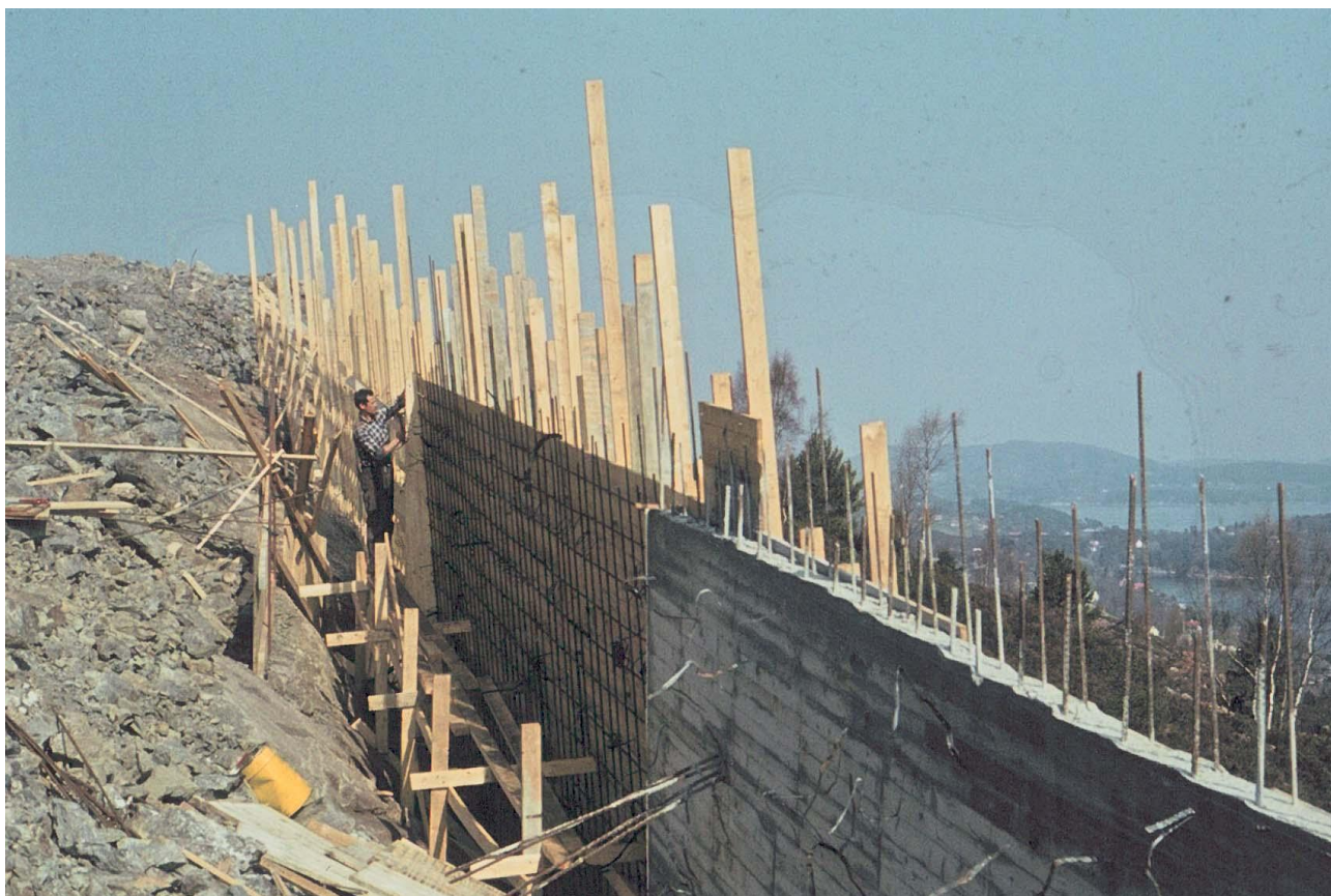
Steinar Stormark setter opp forskalling på vei muren rett ovenfor krysset.
