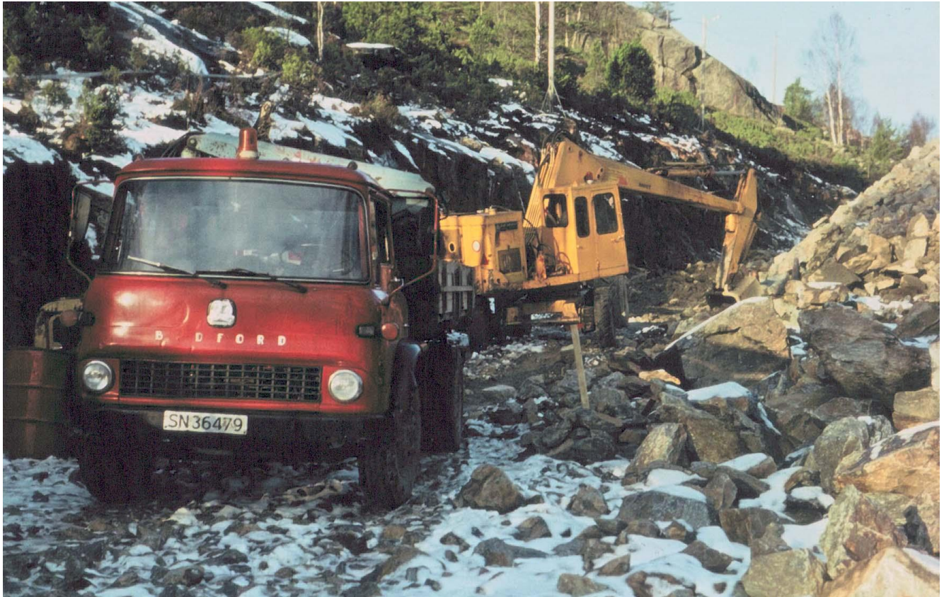
Lagets lastebil og Brøyt ca. 200 meter oppe i feltet. Her er mye sprengstein som skal plasseres før det blir vei av dette.
