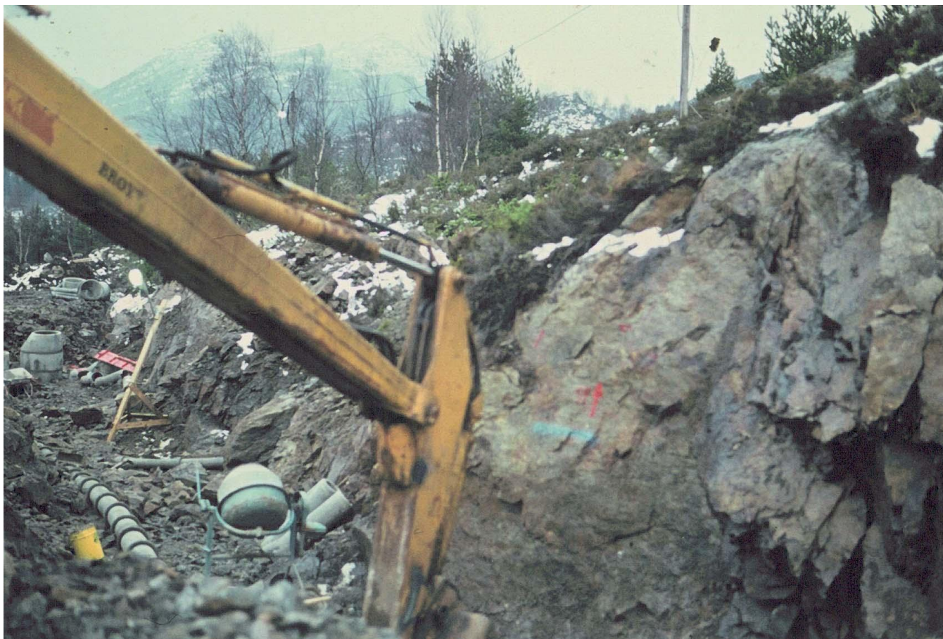
Brøyten i arbeid i veien ca. 50 meter nedenfor krysset i feltet.
