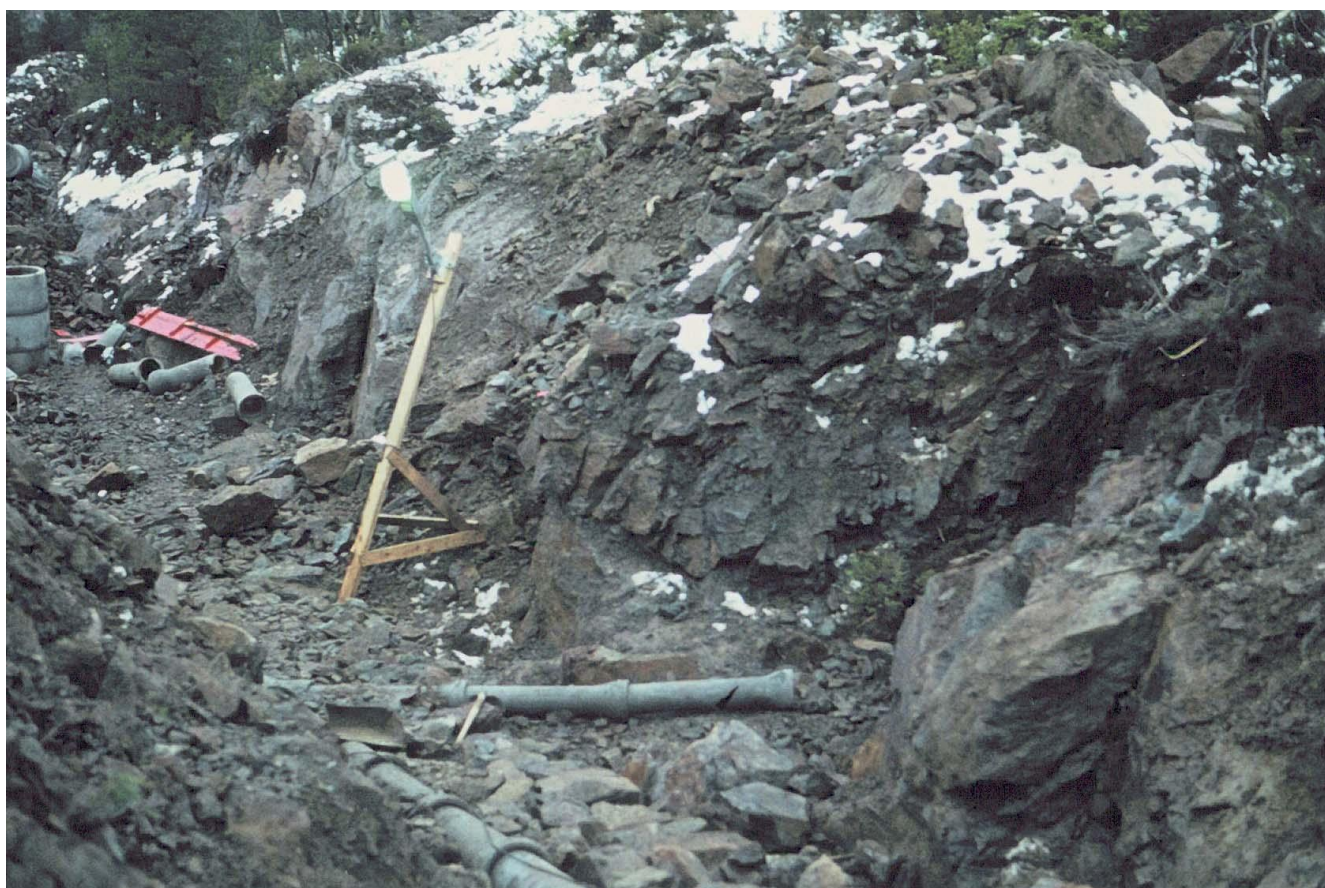
Rørlegging i veien like nedenfor krysset i feltet.
