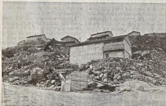
Husene på Thorsen-feltet ligger «bratt i terrenget», ennå står det igjen mye utomhus arbeid før selvbyggerne kan si seg fornøyd.
