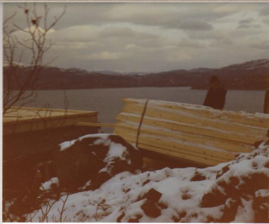
Gulvet lagt ferdig.
