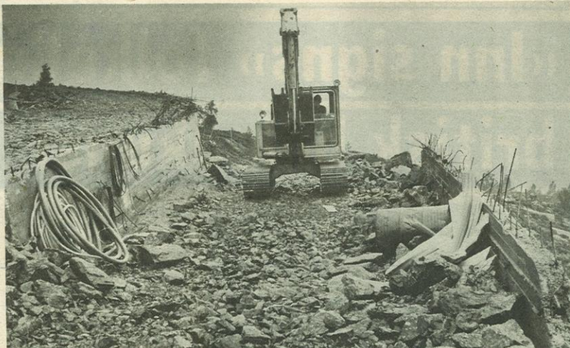
Selvbyggerne er på det nærmeste ferdig med sin del av veiarbeidet — nå er det Hordaland Vegkontor som må ta et skippertak. (Foto: Tor M. Skillestad).
