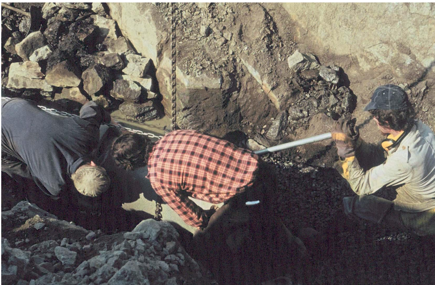
Alle betongrør måtte nøye tilpasses for å bestå kommunens forløpende trykkprøving. Til høyre Geir Storrø.
