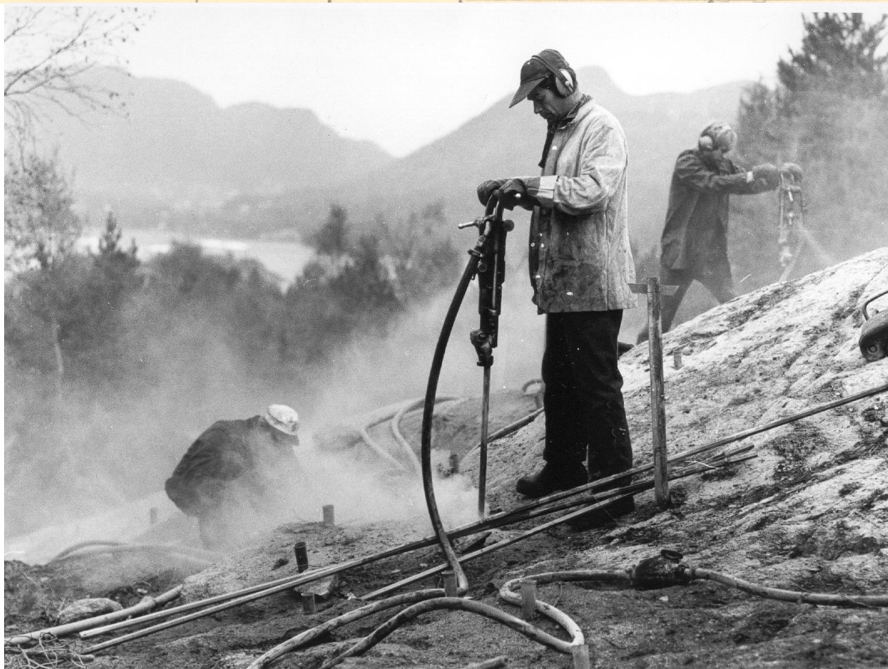
Fra BT. Boring av veien et stykke nedenfor krysset. Midt på bildet Jan Inge Berge.
